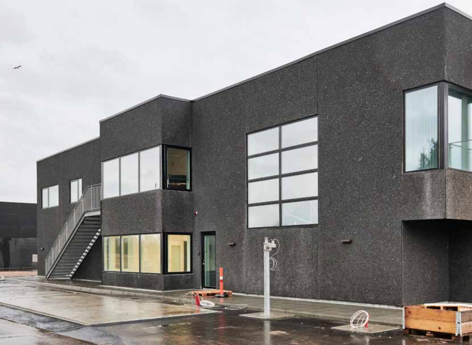
Ny velfærdsbygning på deponi
